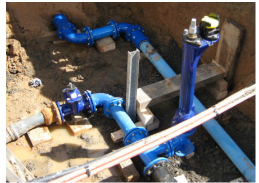
Schieberkreuz Mittelweg/Schönbornweg nach dem Umbau zur Herstellung der Druckzone „MZ 9“
