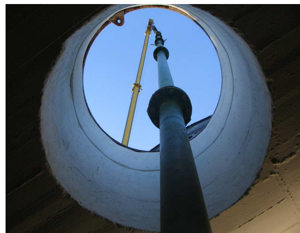
Zur Feststellung des allgemeinen Zustandes der Förderleitung des Trinkwasserbrunnens wurde die über 50m lange Stahlleitung aus dem Brunneninneren gezogen.
