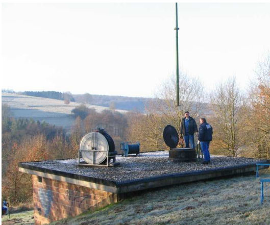
Tiefbrunnen Autal während der Aushebung der Stahlleitung.
