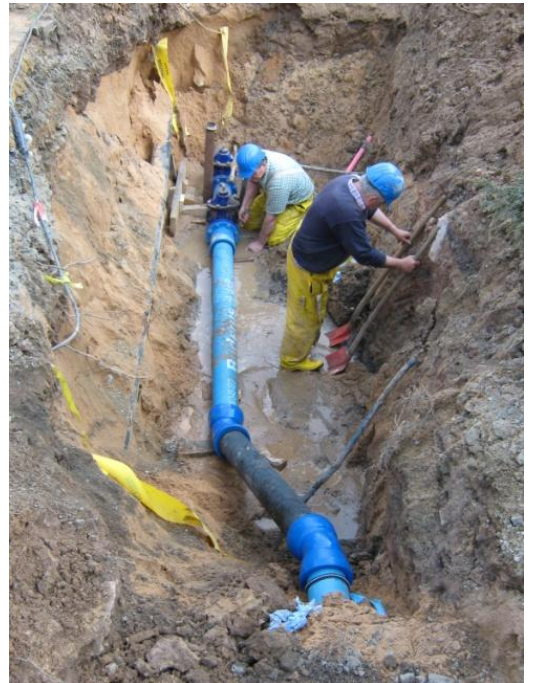
Verantwortungsvolle Arbeit: Neuverlegung der Trinkwasserleitung zur Sicherung der Versorgung unserer Stadt.
